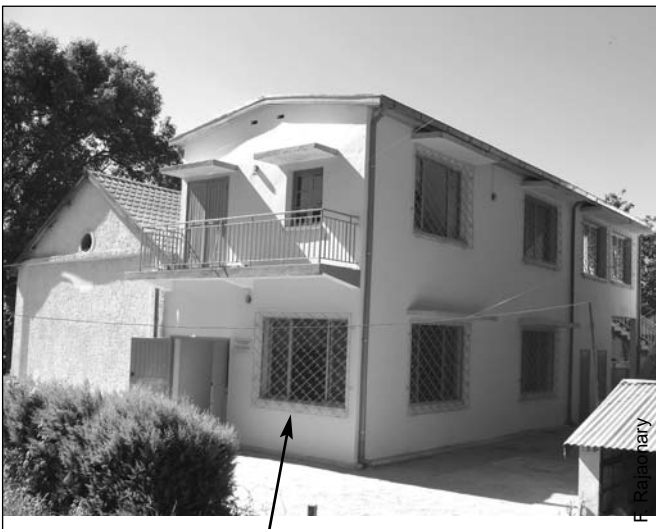
The new building/ le nouveau bâtiment
